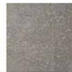
Estructura de baldosas y hormigón
